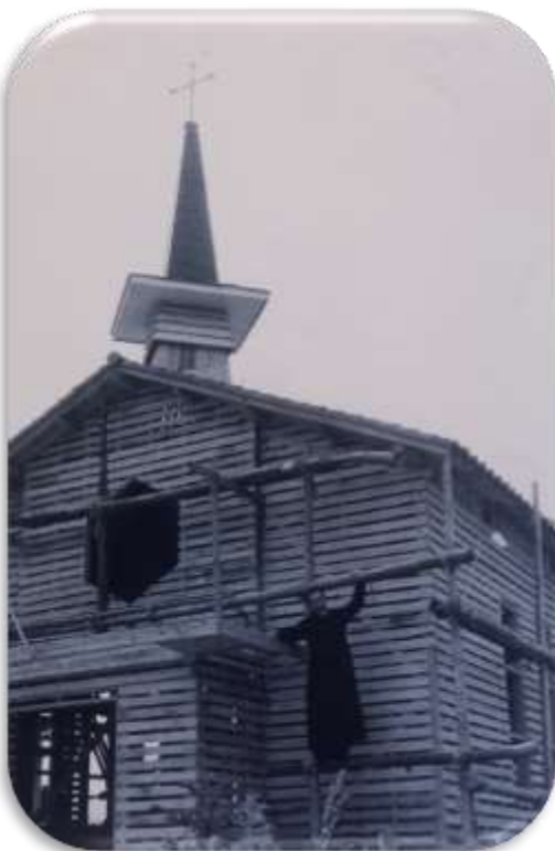
建設中の御聖堂とロミティ神父
